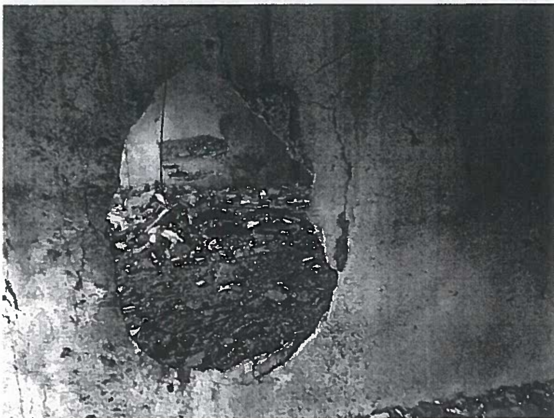
Foto č.11 – Průrazy příčnými nosnými stěnami
