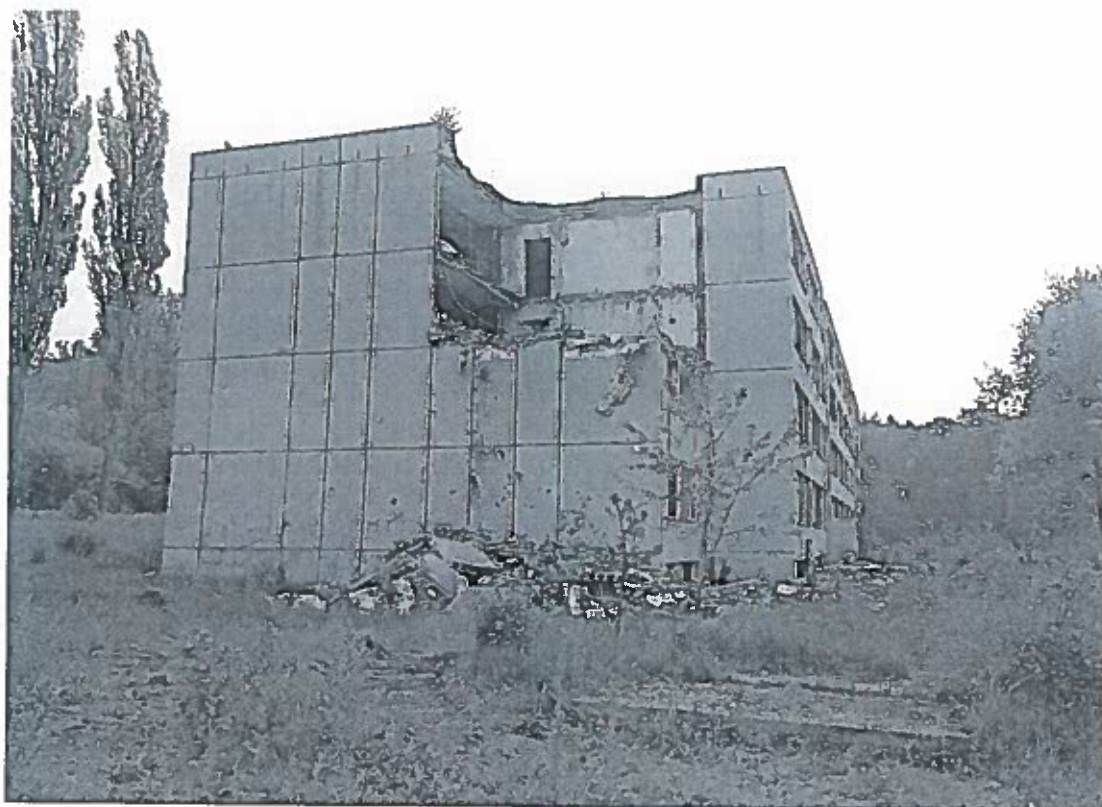
Foto č.2– Rozsah zbourané části objektu při západní štítové stěně
