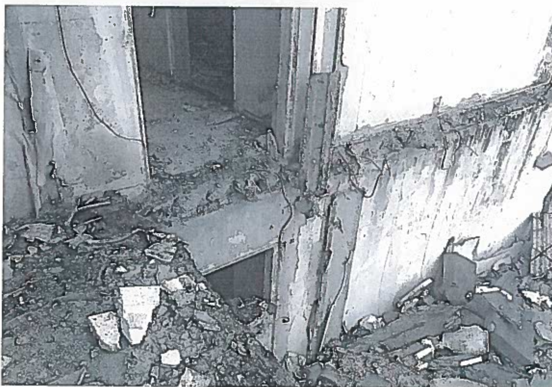
Foto č.2– Rozsah zbourané části objektu při západní štítové stěně
