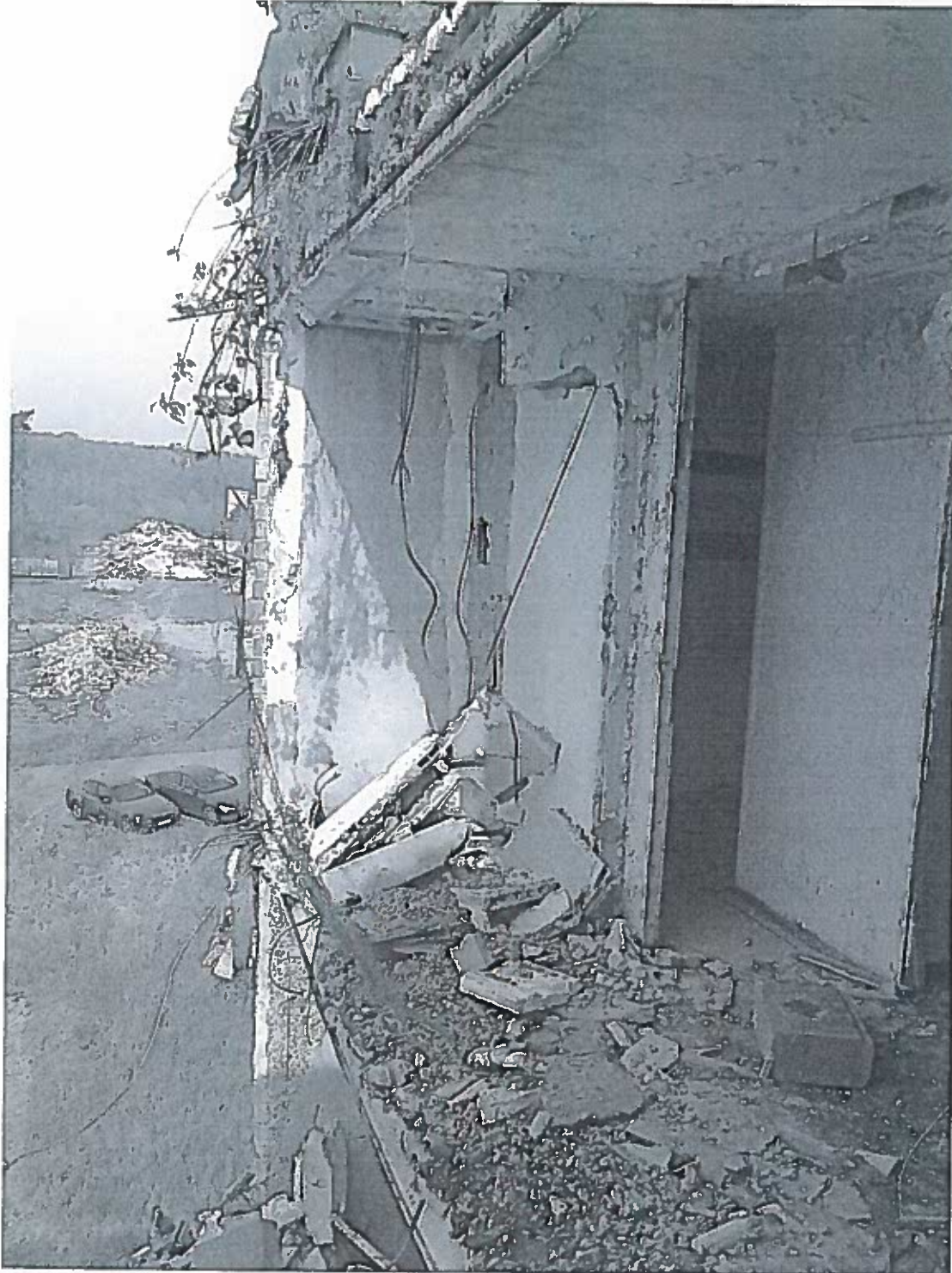
Foto č.8 – Štítová stěna byla zbourána na výšku celého 3.NP a 4.NP
