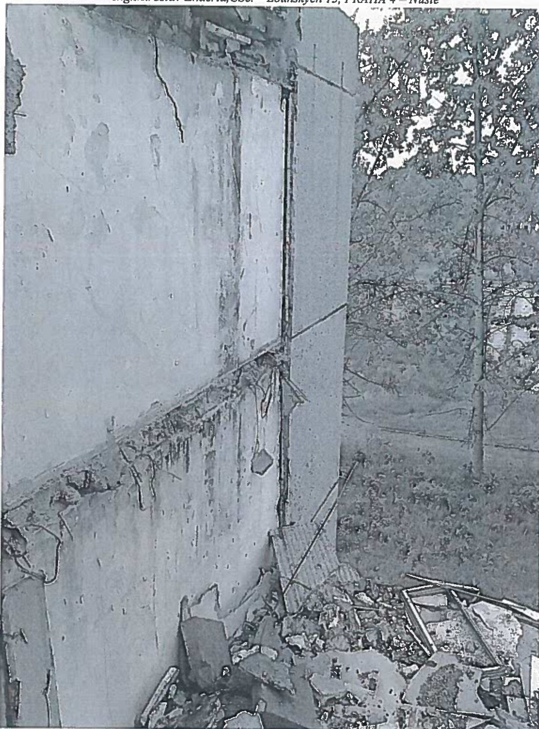
Foto č.4 – První střední nosná stěna zůstala ponechána
